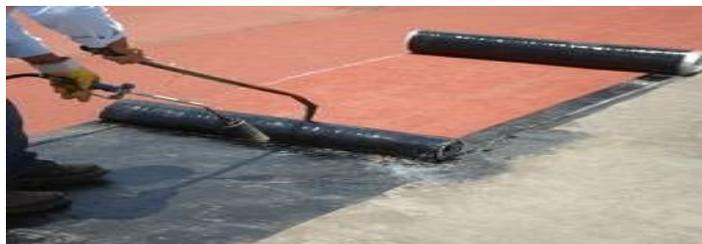
Continuando con la instalación, caliente por medio de soplete de gas (especial para prefabricados), la cara inferior de una sección del manto hasta fundir la película de polietileno que trae integrada, y desenróllelo presionando ligeramente a efecto de que suelde por vulcanización. Repetir esta operación a medida que va extendiendo el rollo de Festermip SBS FV Gravilla.
