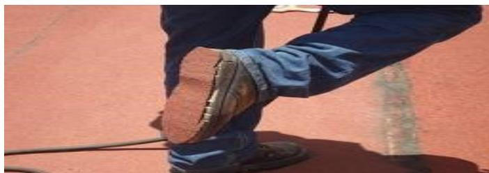
En los traslapes, para mayor seguridad, es conveniente que fluya el asfalto caliente, saliendo aproximadamente 1 cm. Para proteger el asfalto del borde, estando este completamente caliente, hacer riego de gravilla y presionarla para que se adhiera.
